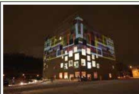
Fassade des SANAA-Gebäudes im farbigen Licht der audiovisuellen Installation „close encounter“ von Eva-Maria Joeressen und Klaus Kessner im Januar 2010 © Foto: Peter Vogt / Bilddatenbank Zollverein
