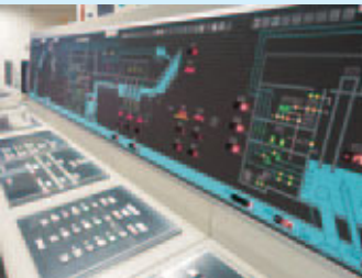
善福寺取水施設の中央監視操作盤。3本の川の様子をモニターで監視しながら、取水システムを1カ所で制御する
