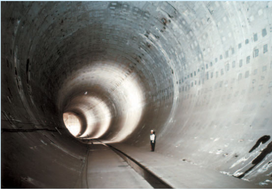
トンネルの内部。満水時は54万tの水をためられる
