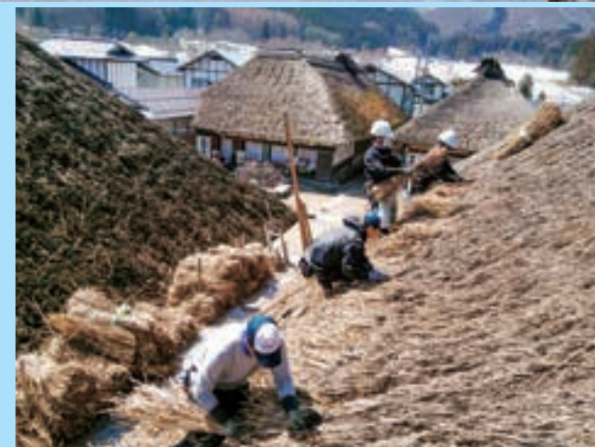
茅手とよばれる職人を中心に住民全員が協力し合い、屋根の葺き替え作業に取り組んでいる
