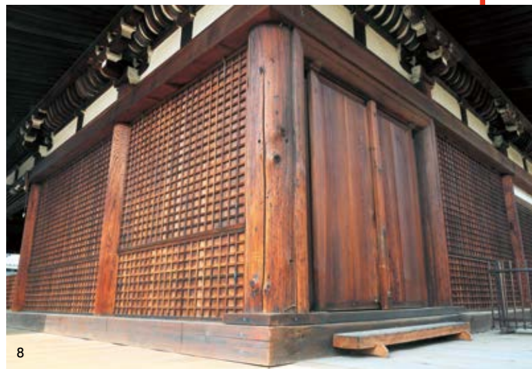
8／約800年前に建立された大報恩寺に取り付けられた部戸（しとみど。写真左手）と呼ばれる建具（写真＝アフロ） 9／木組をする建具職人の鈴木正さん。伝統建具の製作や修理に60年以上携わってきた第一人者で、近年は技術継承にも力を注ぐ（写真提供＝全国伝統建具技術保存会） 10／格子に板をはさんだ部戸の製作風景。格子の木組には、寸分の狂いも許されない（写真提供＝全国伝統建具技術保存会）
